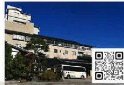
ホテル海望 ☎0767-62-1515 ※解体・建設工事につき、仮営業中
