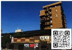
ゆけむりの宿 美湾荘 ☎0767-62-2323 ※解体・建設工事につき、仮営業中
